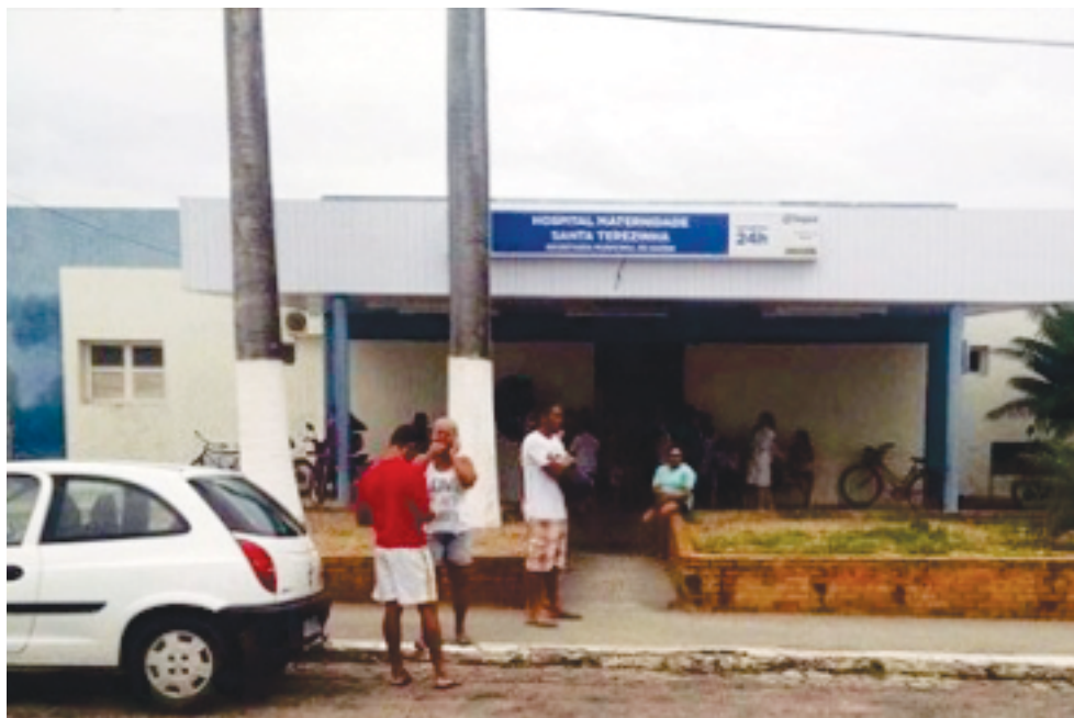
O Hospital Maternidade Santa Terezinha será beneficiado
