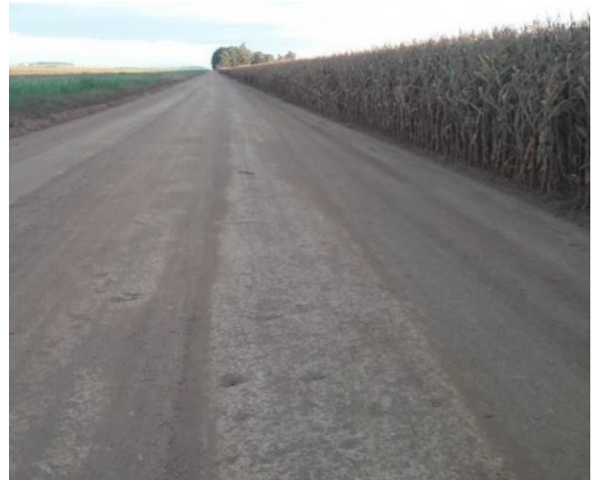
... e, depois do serviço executado
