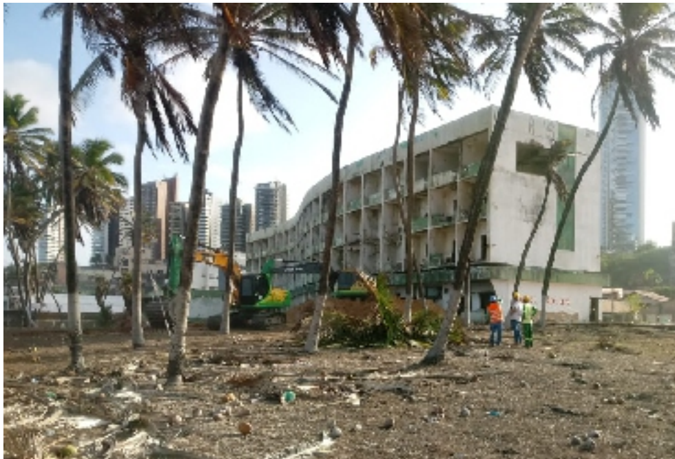
Os operários se preparavam para a derrubada do prédio
